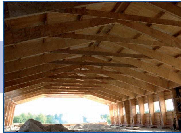
Portique de bâtiment agricole - Lamibois type S
